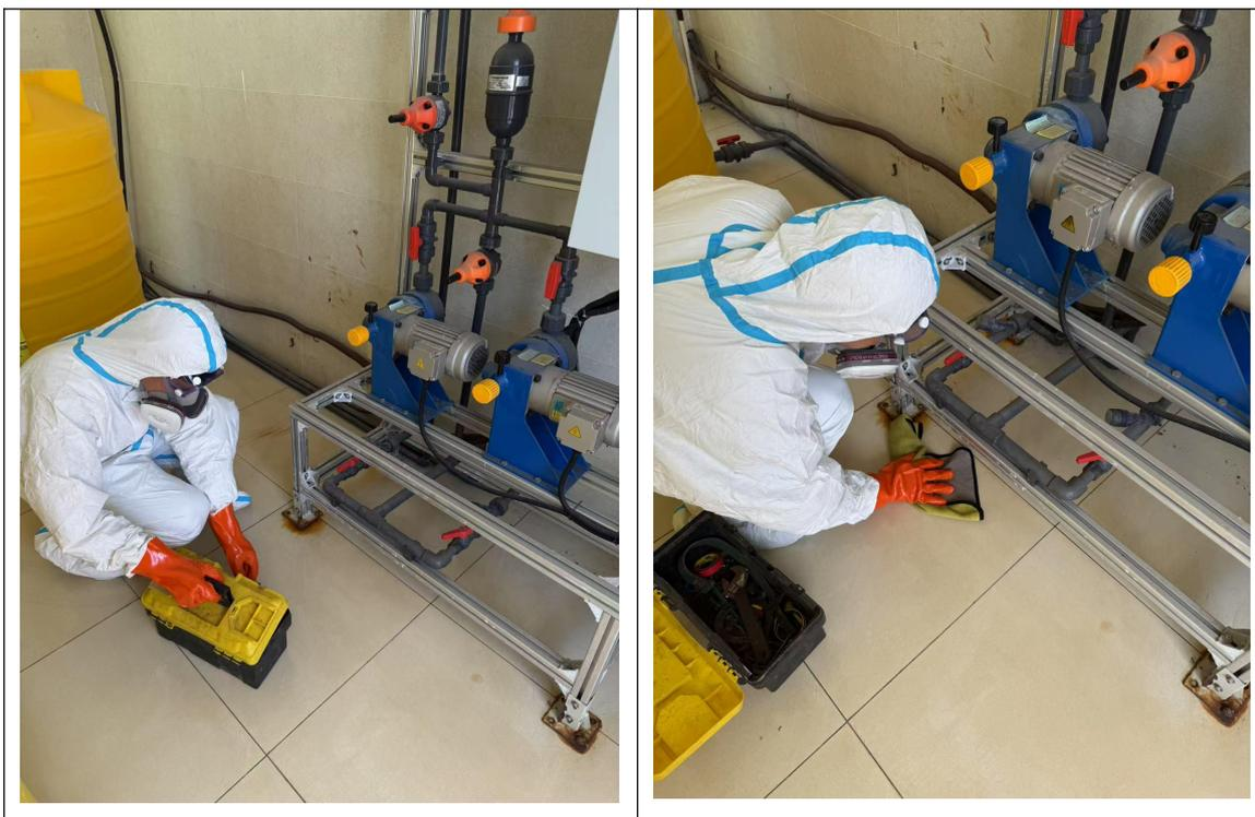
7. 维修人员进场后先关闭设备电源。
